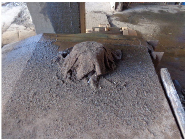
Figuras 7/8 - Respiradouros: sem proteção adequada e com filtro dessecante e de material particulado sólido
