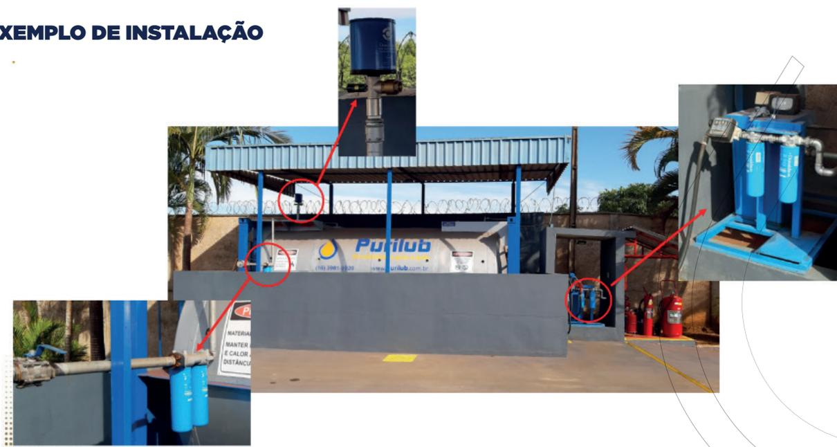
A instalação acima está em nossa matriz, no município de Pradópolis-SP, é uma instalação típica que respeita orientação da Donaldson, ou seja, filtrar ao receber o produto, preservar puro enquanto estocado e “polir” ao abastecer o veículo ou o tanque de transferência.
